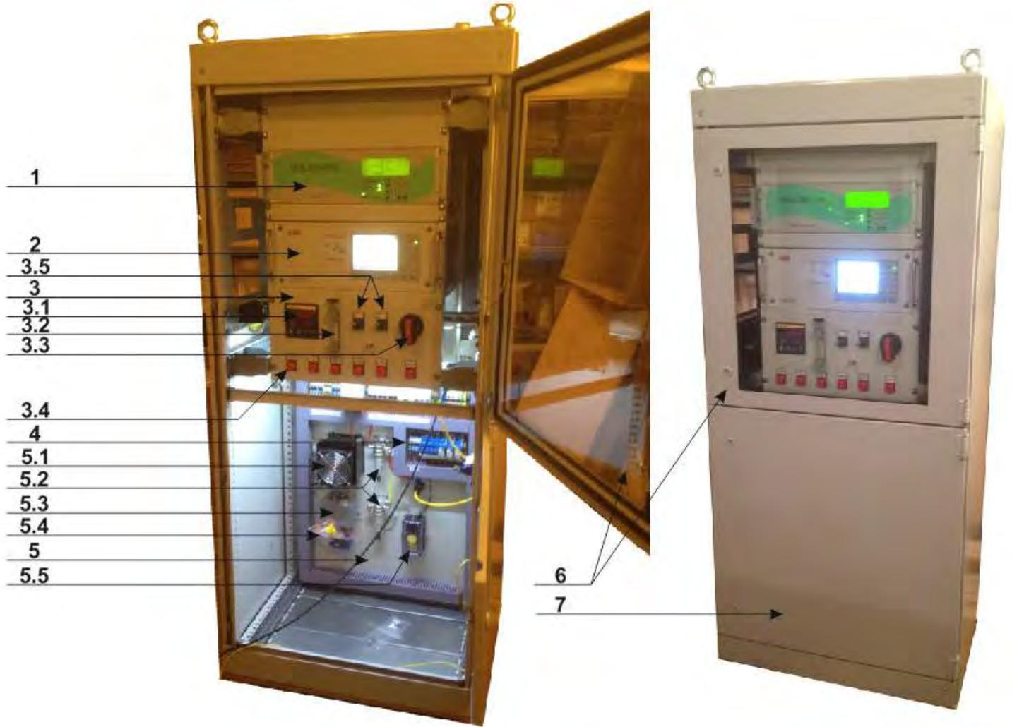
Рис. 1 Газоанализатор «МАК-2000-UMS» в 19” корпусе в шкафу 1800x800x600 мм (пр-во «Провенто» или др.)
